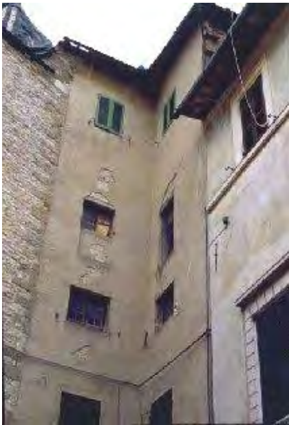
Distacchi di intonaco
