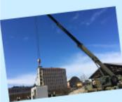
fase di fornitura dei moduli durerà all'incirca quattro settimane, prevedendo il posizionamento di circa 6 moduli al giorno per un totale di 96 moduli complessivi componendo così la configurazione dell'alloggio tipo, che prevede 2 posti letto e un bagno completo.
